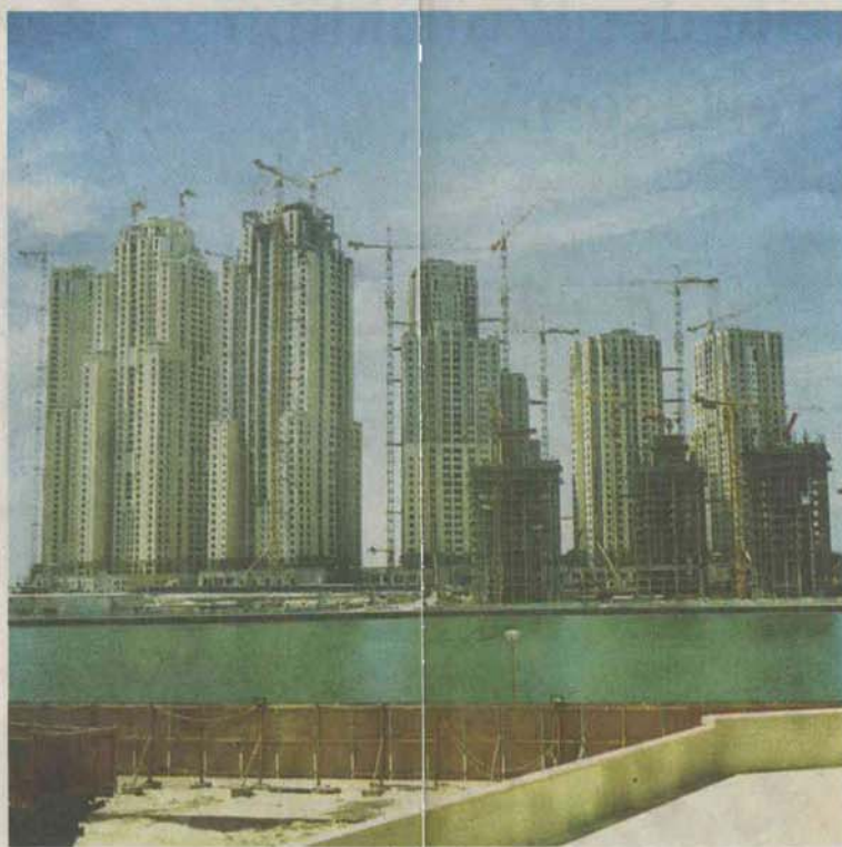
Jetzt stehen die Kräne still: Baustelle in Dubai
